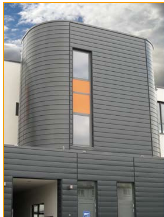
Med / uden skyggefuge (20 mm) Lige Fuge Uden mikroliniering Opsætning oppe fra og nedad
